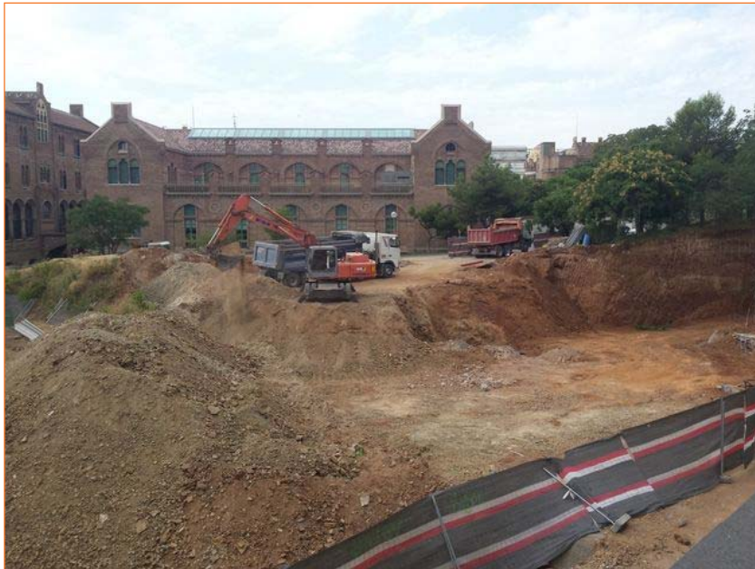
Foto 2. Vista general cap al sud est dels treballs de rebaix del solar
