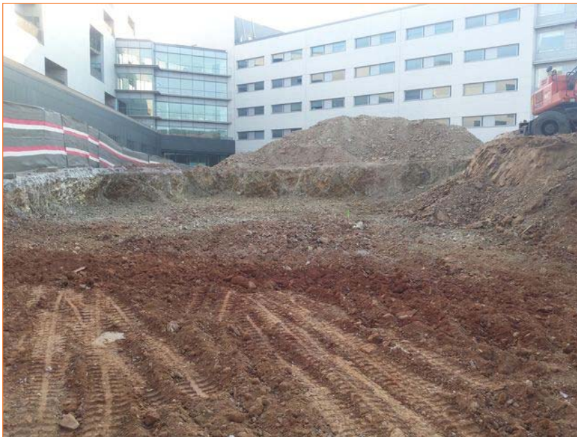
Foto 4. Vista NE de l'esplanada un cop rebaixada
