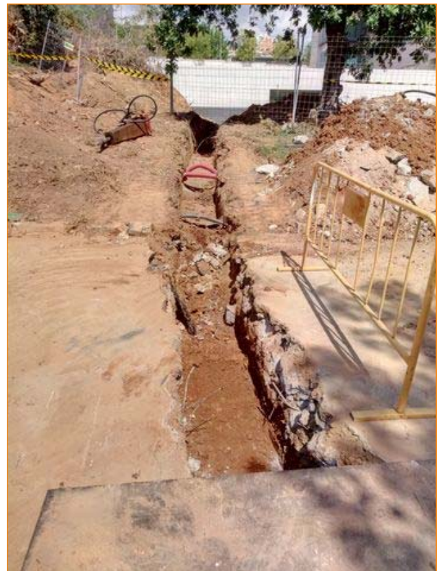
Foto 22. Vista final nord de la rasa finalitzats els treballs de rebaix
