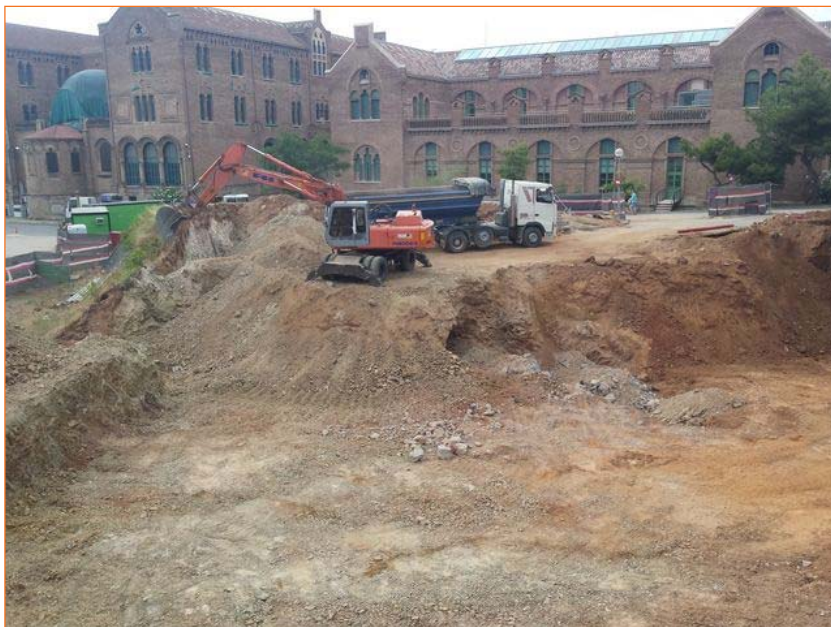
Foto 8. Vista SE del rebaix de la zona enjardinada NE
