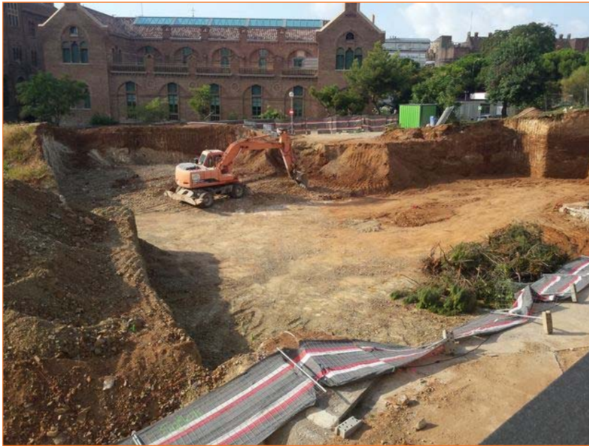
Foto 3. Vista general final del rebaix del solar
