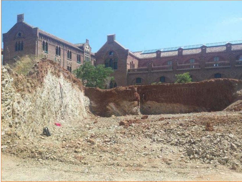
Foto 9. Vista final SE de la zona enjardinada ja rebaixada en la totalitat
