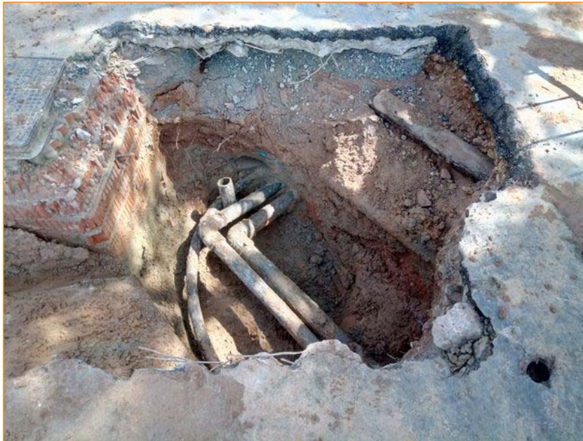
Foto 23. Vista final de la cala finalitzats els treballs de rebaix
