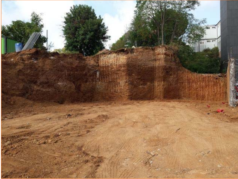
Foto 17. Vista sud del perfil de l'enjardinament SO finalitzats els treballs de rebaix
