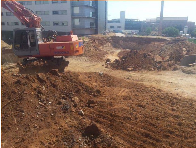
Foto 7. Treballs de rebaix de la zona enjardinada NE
